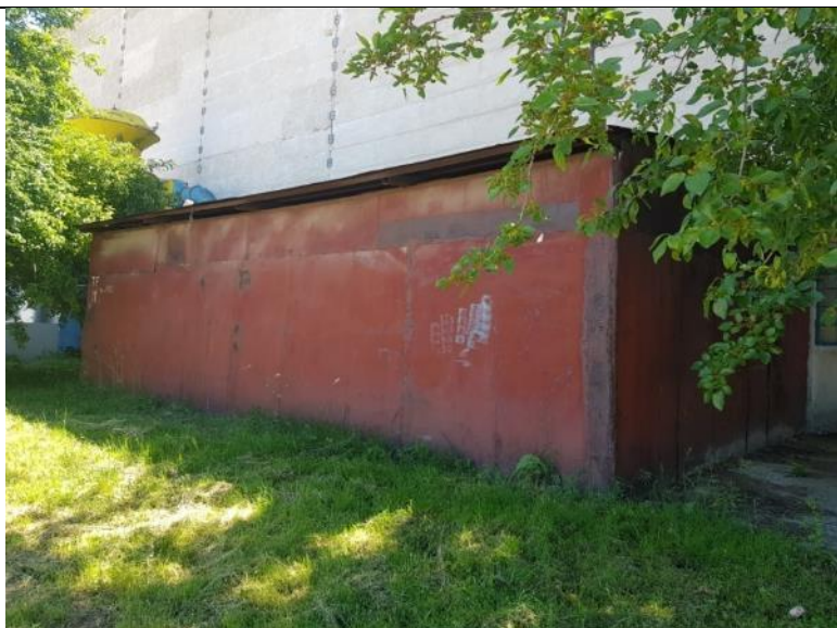
C325 | Atelier întreținere STM cu sc la sol de 184 mp, an pif 1995
