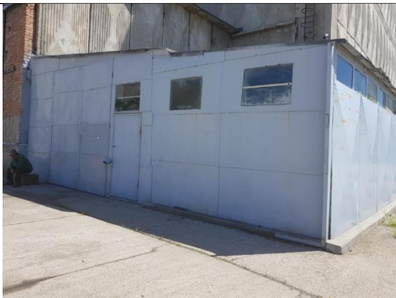
C347 | Magazie materiale izolații uscate cu sc la sol de 40 mp, an pif 1995
