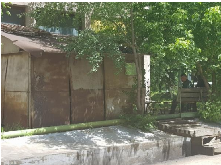
C339 | Șopron cu sc la sol de 349 mp, an pif 2004
