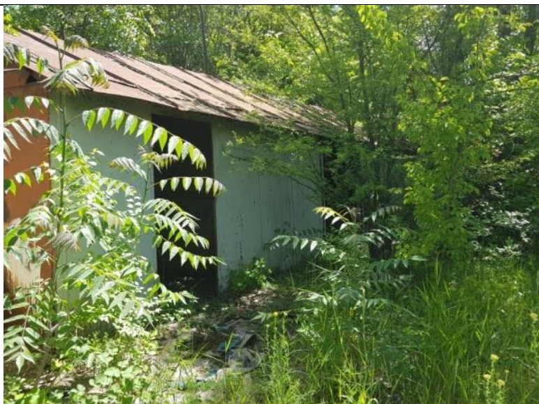
C215 Platformă asfaltată pentru lubrefianți și construcții cu sc la sol de 68 mp, an pif 2004
