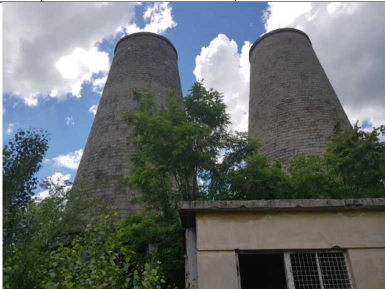
C157 | Platformă depozitare izolatori și construcții aferente cu sc la sol de 46 mp, an pif 1982
