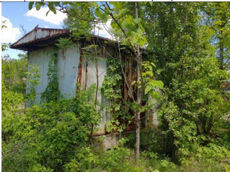
C259 | Clădire stație de distribuție și posturi de transformare Y 110Kv, cu sc la sol de 199 mp, an pif 1972, cu regim inaltime P+2
