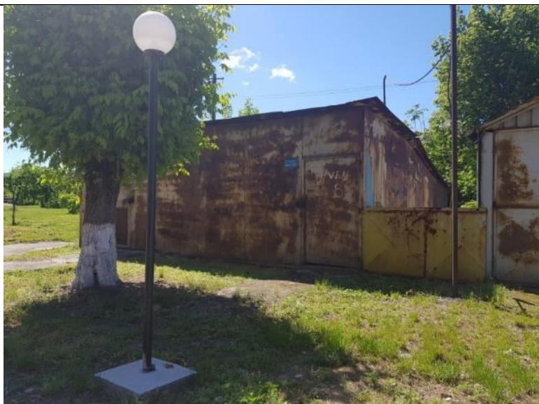
C302 | Garaj auto cu sc la sol de 142 mp, an pif 1995
