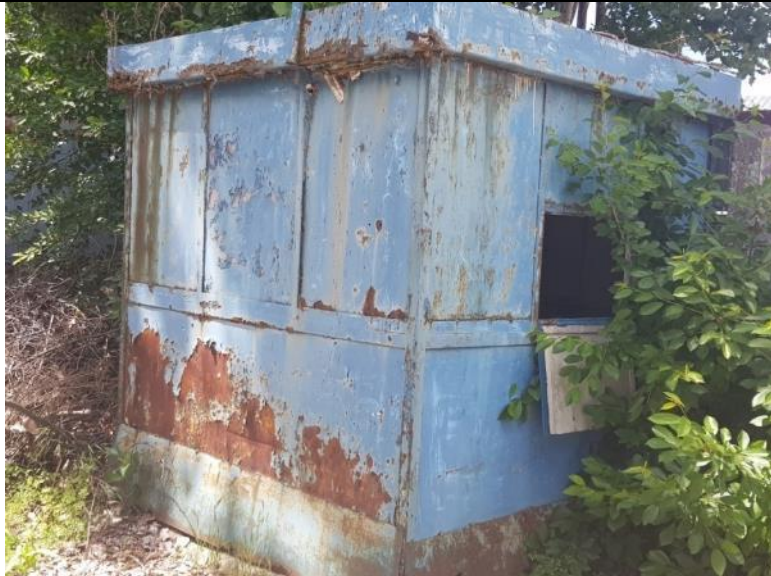
C2-fost C271 - Cantina cu autoservire cu sc. la sol 1182 mp, an pif 1972
