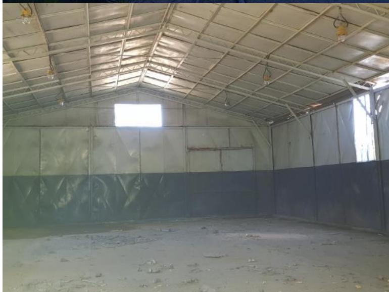
C83- baraca metalica nr. 1 cu sc. 243 mp, an pif 1996
