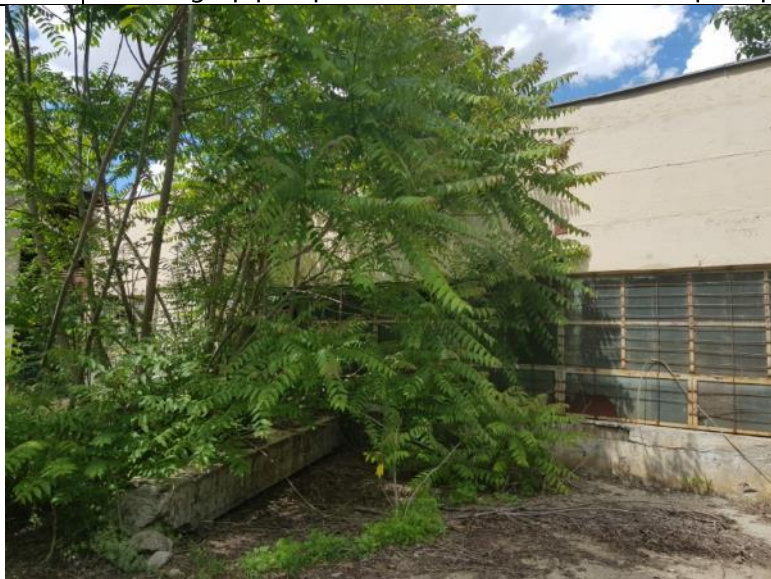
C165 Puț rezervor cu sc la sol de 110 mp, an pif 1972
