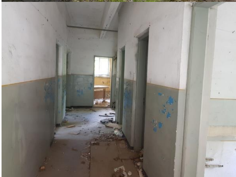
C193 | Clădire laborator defectoscopie cu sc la sol de 239 mp, an pif 1964
