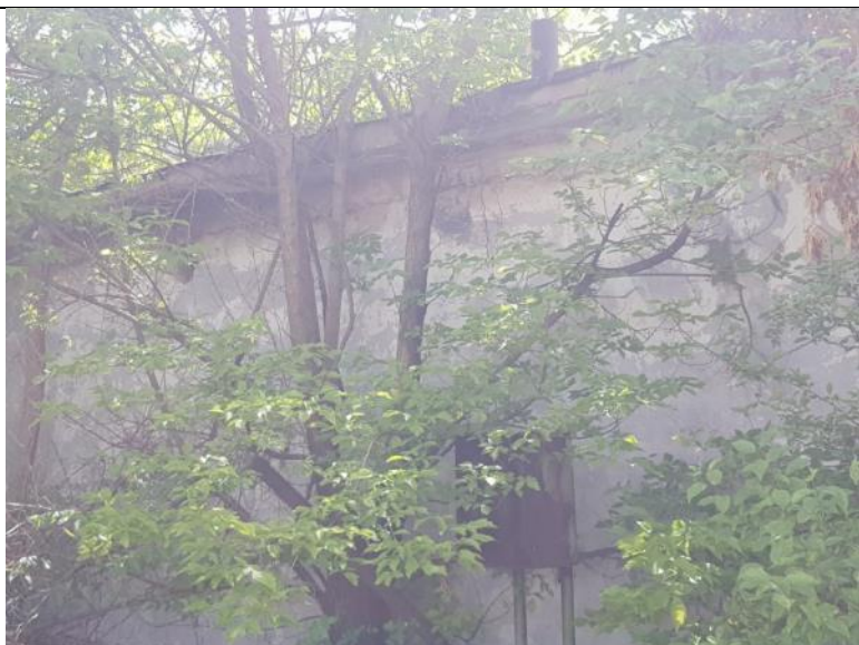
C159 | Centrală termică cu sc la sol de 1407 mp, an pif 1978
