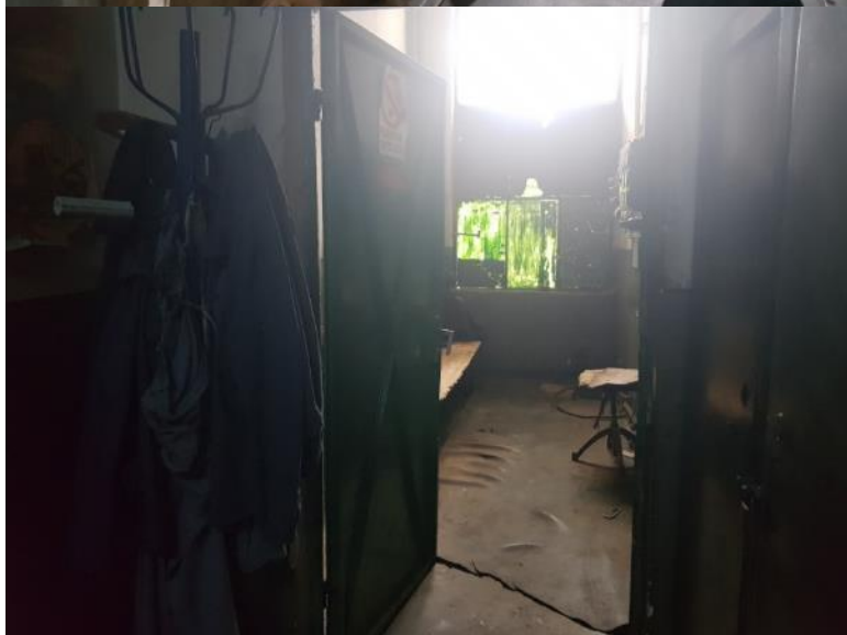
C164 Clădire grup pompe căldură cu sc la sol de 176 mp, an pif 1986
