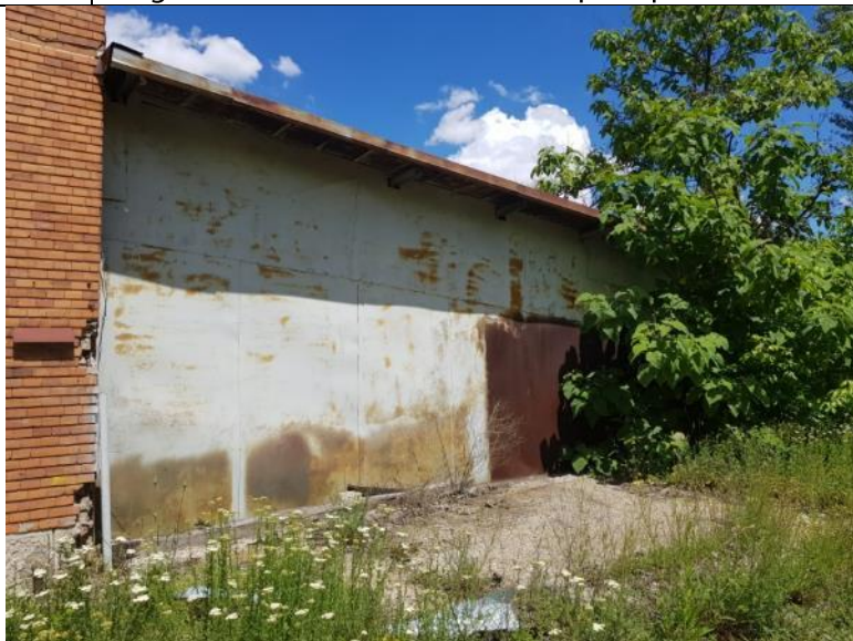
C206 | Depozit de chimicale și inflamabile cu sc la sol de 801 mp, an pif 1963
