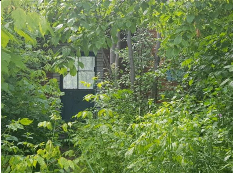
C145 | Șopron deșeu hârtie cu sc la sol de 367 mp, an pif 1978
