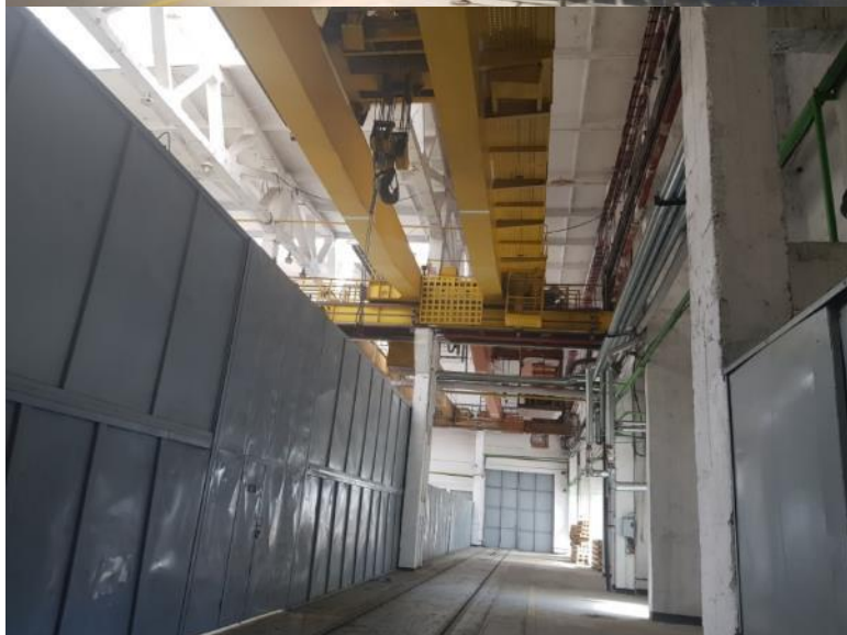
C329 | Magazie materiale cu sc la sol de 57 mp, an pif 1993
