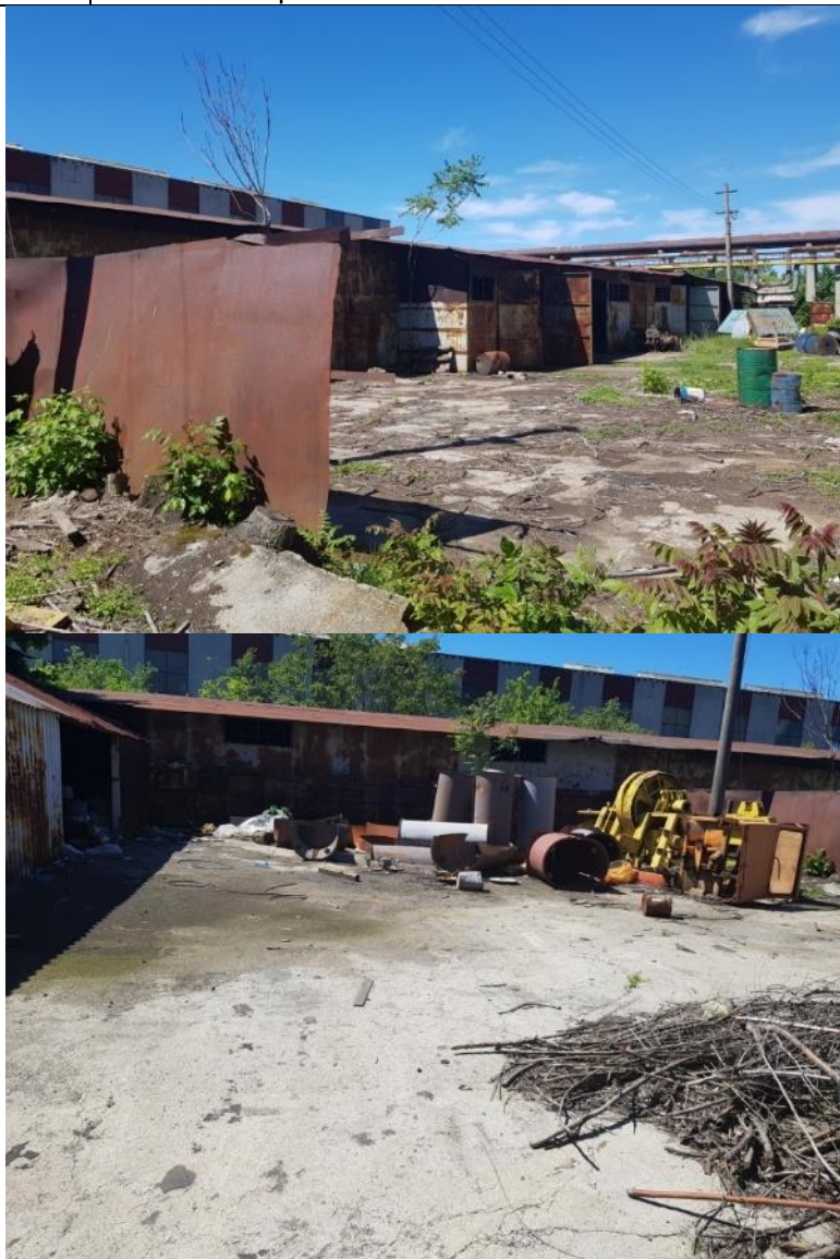
C305 Depozit general cu sc la sol de 2741 mp, an pif 1981
