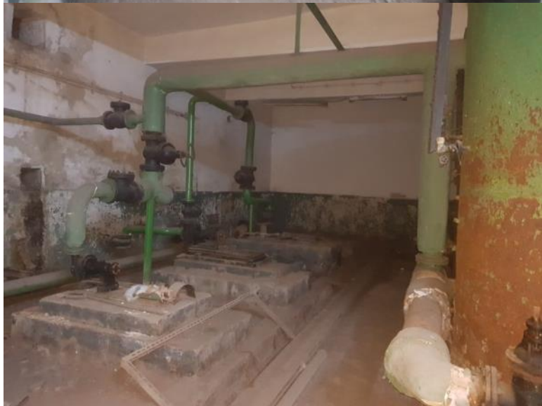
C299 | Hală pavilion STM cu sc la sol de 611 mp, an pif 1994, regim inaltime P+3
