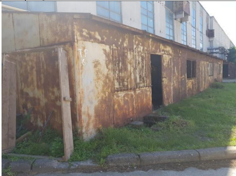
C331 | Atelier întreținere STM cu sc la sol de 106 mp, an pif 1995
